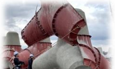
テトラポッド型枠
